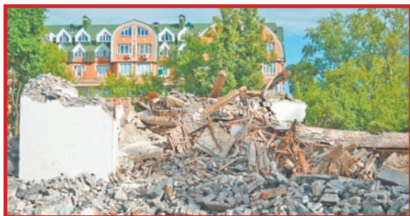
ДЕТСКИЙ САД СНЕСЛИ, ЧТОБЫ ПОСТРОИТЬ НОВЫЙ
