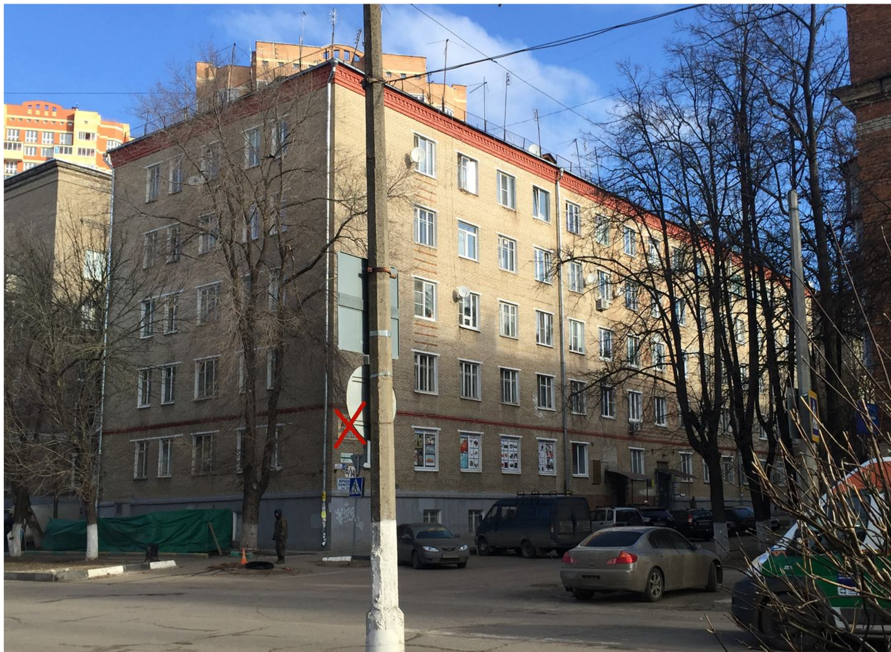
Фотофиксация. Существующее положение.
