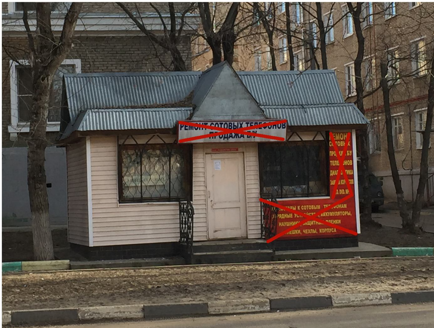
Фотофиксация. Существующее положение.
