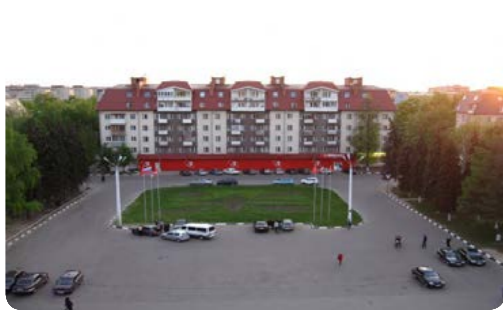
Площадь города до реконструкции.
