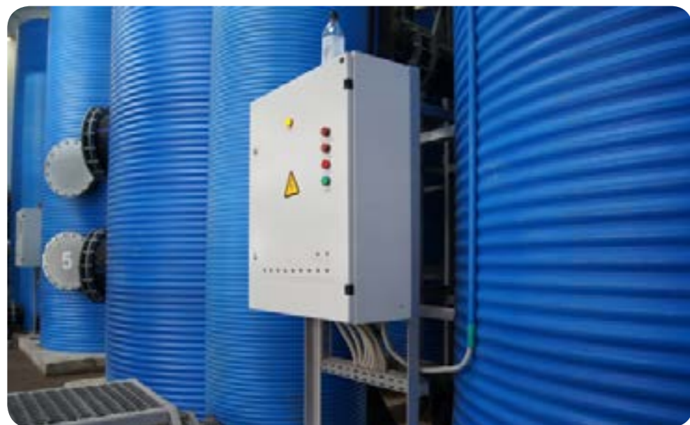
Новая станция обезжелезивания. Производительность станции 10000 куб.м./сутки. Пробурена артезианская скважина на 60 куб.м. воды в час. Обеспеченность населения чистой водой выросла до 99,3 %.
