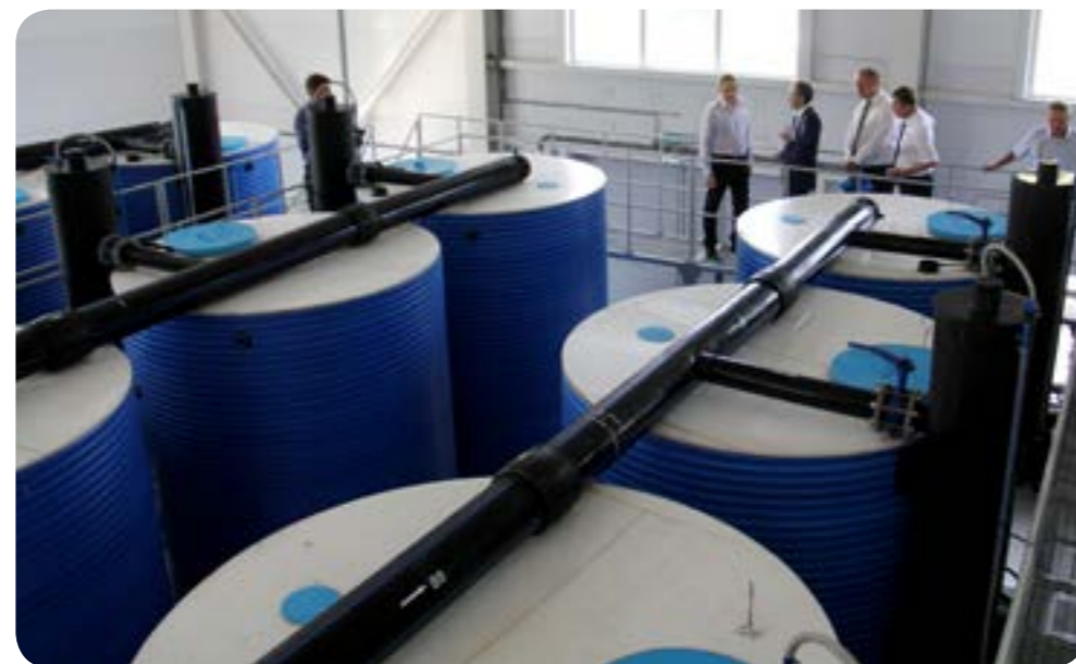
Новая станция обезжелезивания. Производительность станции 10000 куб.м./сутки. Пробурена артезианская скважина на 60 куб.м. воды в час. Обеспеченность населения чистой водой выросла до 99,3 %.
