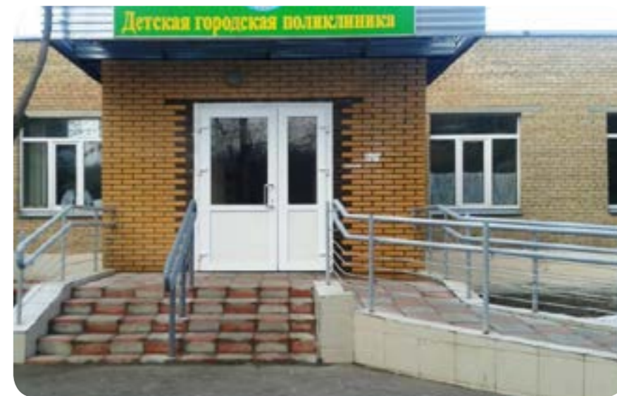
Кпитальный ремонт помещений поликлиник № 2 и детской поликлиники, 2017 г.
